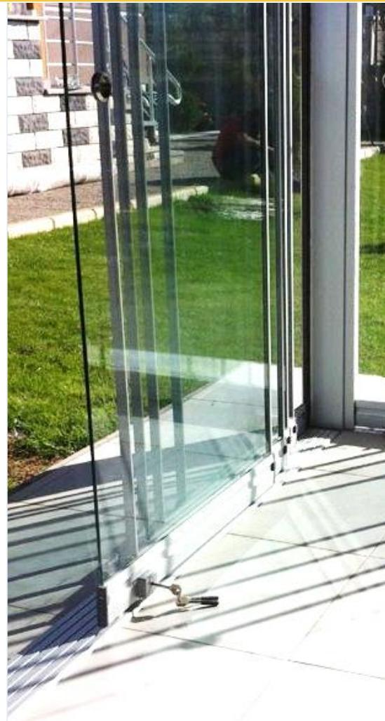
Остекление веранды в частном доме, высота остекления больше 2 метров. Установка такого остекления является достаточно сложной работой, начиная с замера и заканчивая монтажом.
